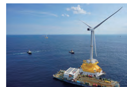
5MWアドバンストスパー型浮体式洋上風車 (福島沖)
